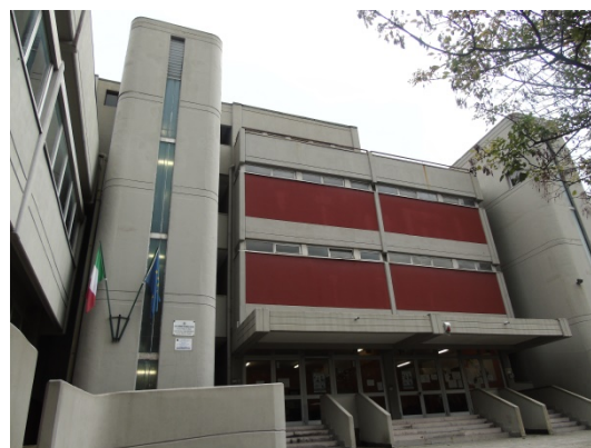
Figura 1.1 - Vista della facciata esposta a nord-ovest (ingresso scuola primaria)
