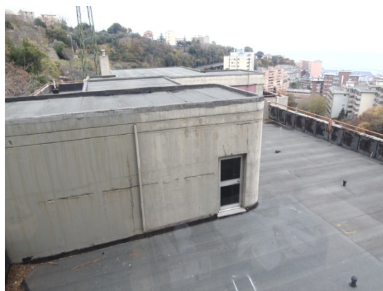
Figura 4.2 - Particolare della coperture piana
