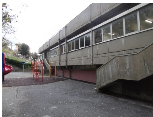
Figura 8.1 – Particolare della facciata da isolare esposta a nord-ovest
