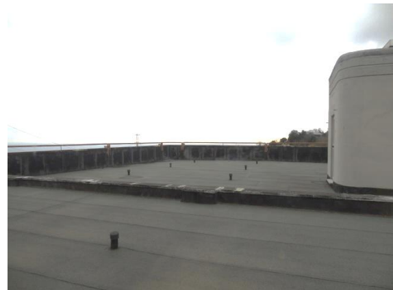
Figura 8.5 - Particolare copertura piana su cui intervenire
