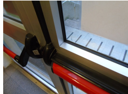
Figura 8.3 - Particolare serramenti da sostituire e delle attuali valvole dei radiatori, prive di testina termostatica
